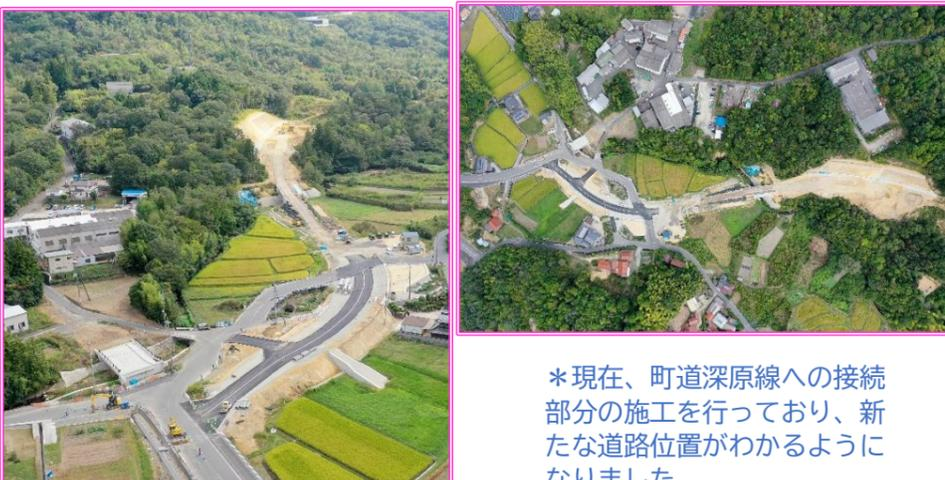
\* 現在、町道深原線への接続部分の施工を行っており、新たな道路位置がわかるようになりました。これから橋台へ接続する為の施工を行っていきます。
